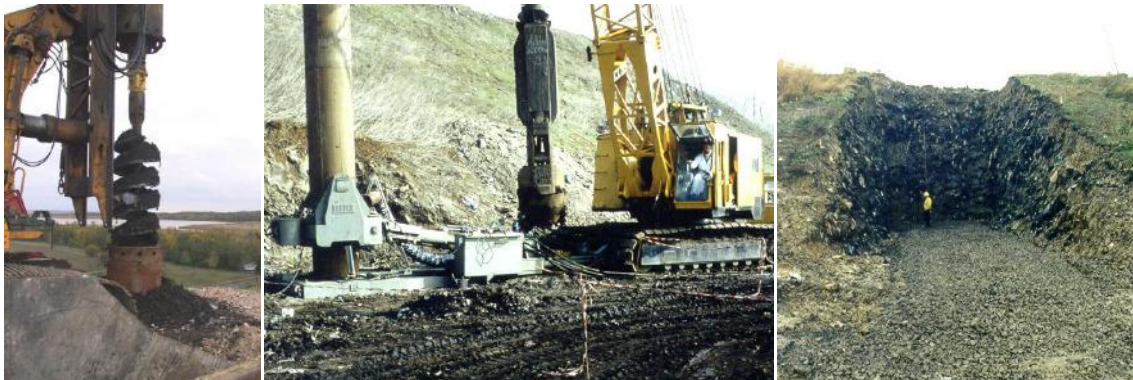
Abbildung 2-2: Schneckenbohrung, Greiferbohrung und Großschurf in Hausmülldeponien
