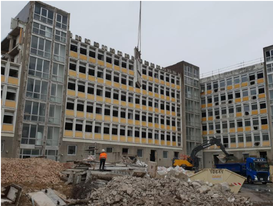
Abb. 2: Beispiel für Rückbau eines Bürogebäudes, Berlin (Fa. Halter)
